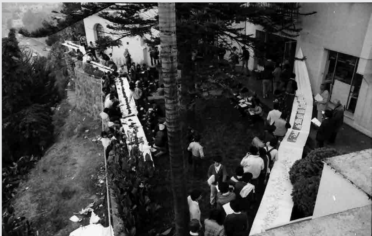
Los bordes del patio acogen la recepción de primer año, 1982.
