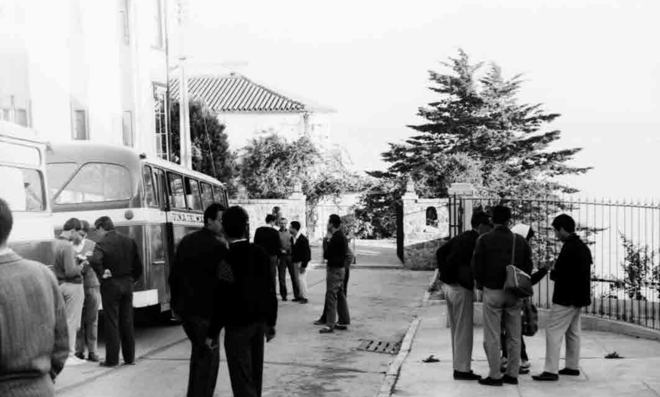
Acceso desde calle Matta, 1964.
