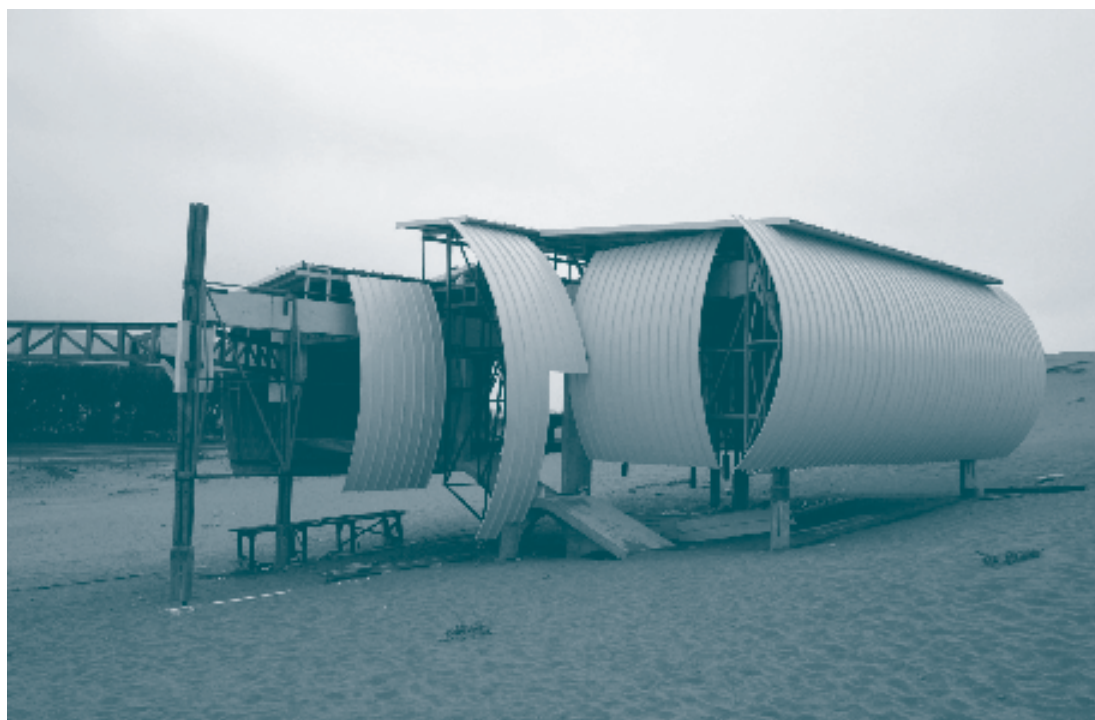
Figura 5: Ciudad Abierta: En las dunas. Hospedería Colgante: Suspendida en el viento. Absorbe la vibración del suelo.
